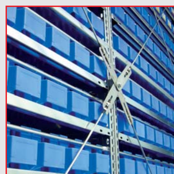
Anbindung der Vertikalauskreuzung und Fachböden
