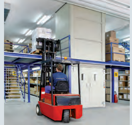
Über Aufzuanlagen gelangen Personal und Ware problemlos in obere Ebenen
